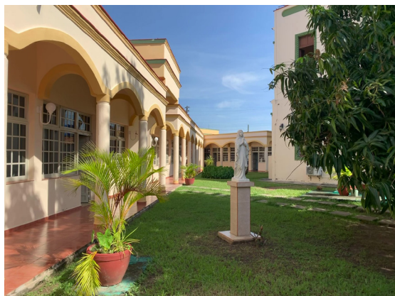
Ampliación y remodelación de la casa diocesana Ntra. Sra. de Loreto
